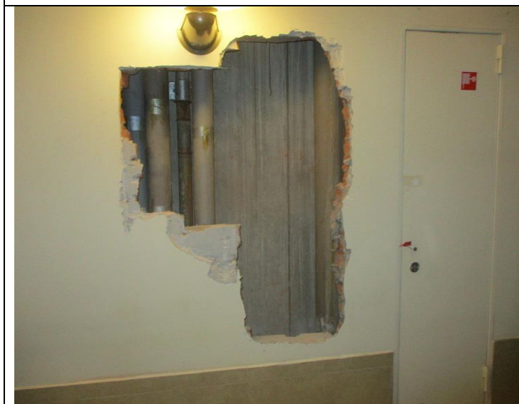
Кор.3, эт.1 Вестибюль Устройство кирпичной кладки -устройство кирпичной кладки
